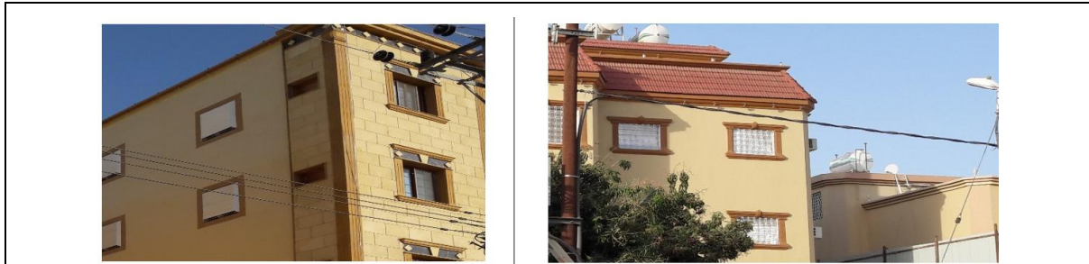
شكل رقم (9) يوضح معالجة الفتحات في حي الأمير مشعل عن طريق سد هذه الفتحات بألواح من الصاج المطلي باللون الأبيض
