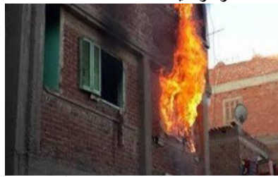
الخطر التعرضي الرأسي وعدم تنفيذ اشتراطات البناء
