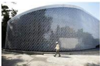
شكل (10) استخدام الزجاجات البلاستيكية كمادة بناء تدعم التقليل من استهلاك الموارد الجديدة.
