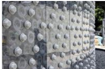
شكل (10) استخدام الزجاجات البلاستيكية كمادة بناء تدعم التقليل من استهلاك الموارد الجديدة.
