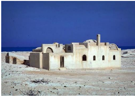
شكل (14) يوضح منزل حسن فتحى فى سيدى كيرى- كاول مثال من المنازل المبنية بالحجر الجبرى فى المنطقة، و مطلى بالمونة طبقا للظروف المناخية المحلية
