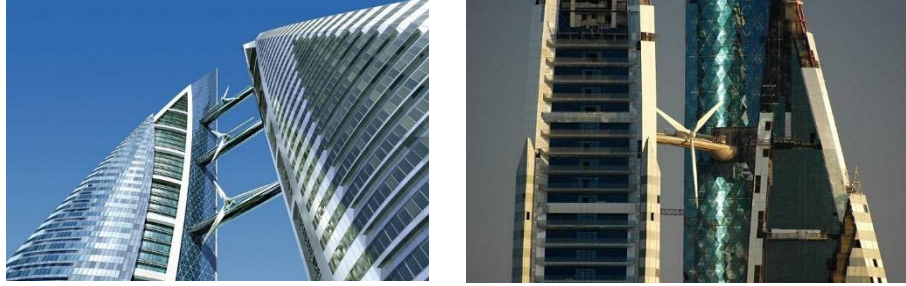
شكل (12) يوضح برج البحرين التجاري واستخدام التوربينات الموفرة للطاقة وهي قادرة على تزويد الطاقة من 11 - 16% من إجمالي استهلاك الطاقة في البرجين، وهو ما يعادل توفير الكهرباء لـ 300 منزل في مدينة.
