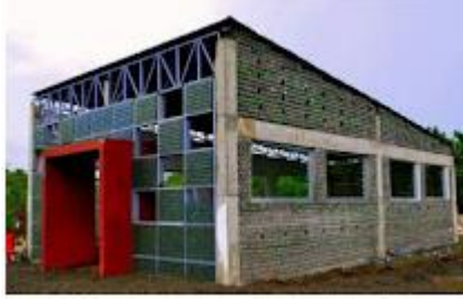
شكل (10) استخدام الزجاجات البلاستيكية كمادة بناء تدعم التقليل من استهلاك الموارد الجديدة.
