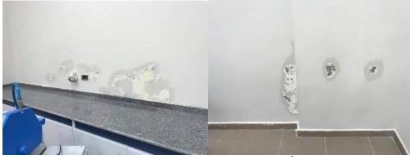
شكل (34) تششير الدهان بسبب الرطوبه في مبني هندسه جامعه حورس المصدر: الباحث
