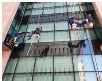
شكل (33) الزجاج التقليدي اثناء اعمال الصيانه المستمره بجامعة حورس المصدر الباحث
