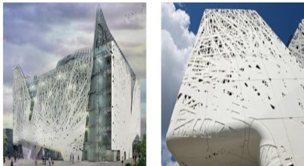
الشكل (18): يوضح استخدام الأسمنت المقلل للتلوث بمبنى The Palazzo Italia ذو الغلاف المنقي للهواء.
