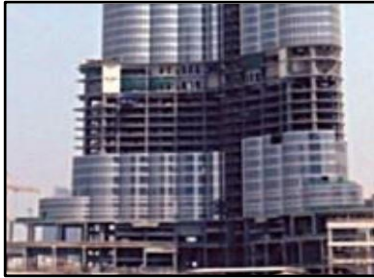
الشكل (12): يوضح برج خليفة الذي استخدمت خرسانة النانو سيليكيا في الهيكل الأساسي للمبنى.
