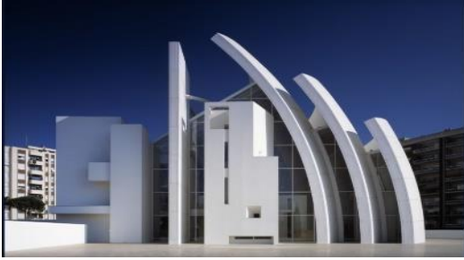
الشكل (14): يوضح استخدام ثاني أكسيد التيتانيوم بالهيكل الخرساني بالكنيسة لإكسابها خاصية التنظيف الذاتي.
